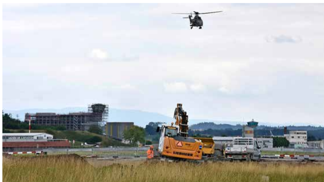
Au sud de la base, les travaux ont déjà débuté.
